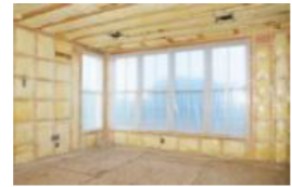
天井・壁等の断熱改修工事
