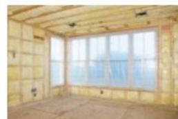
天井・壁等の断熱改修工事
